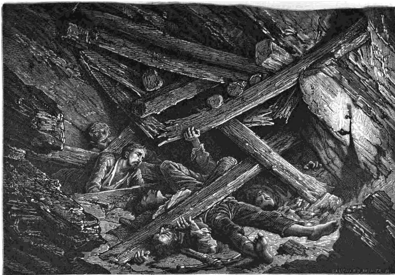
Rupture d'un soutènement
